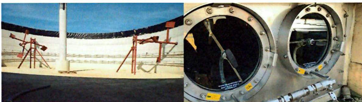
*Digesteur avec isolation et gazomètre, réseau de chauffage interne, agitateurs lents à pâles, hublots de contrôle similaire à la situation présente sur le site d'ABH ENERGIES (CA02)*
