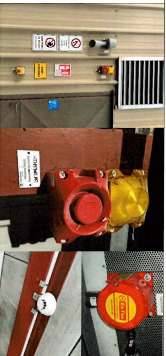
Photos : Alarmes sonores et visuelles, détecteurs de fumées et de gaz sur une unité de méthanisation similaire à ABH ENERGIES (CA02).
